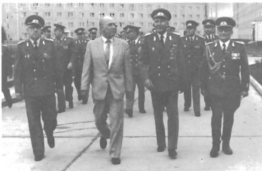
Während eines Rundganges überzeugt sich Armeegeneral Heinz Hoffmann von den guten Studienbedingungen im neuen Objekt
