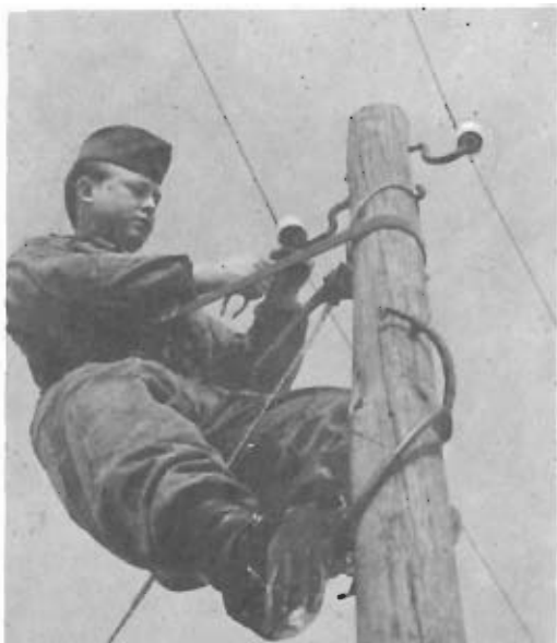
Grenzsoldat bei der Reparatur des Grenz- meldenetzes
